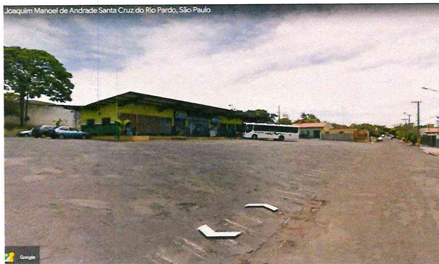
FIGURA 15: Terminal Rodoviário Atual.
