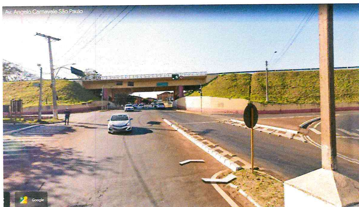
FIGURA 9: Passagem em subnível junto a rodovia SP 225, Eng. João Baptista Cabral Rennó
