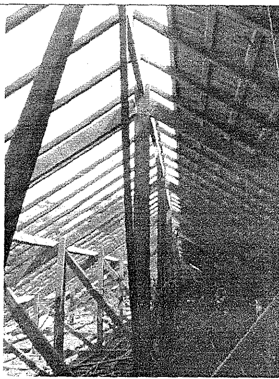
FOTO DO TELHADO PARCIALMENTE SUBSTITUÍDO
